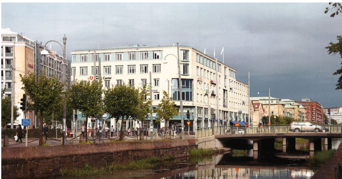
Foto från väster som visar byggnadens befintliga utseende. Foto från GAJD Arkitekter
